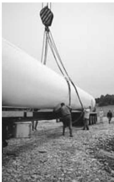
Déchargement du mât.
