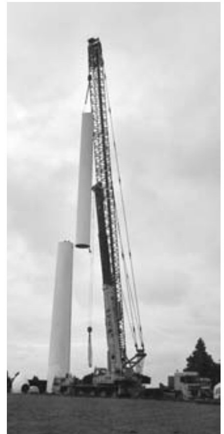
Montage du mât.
