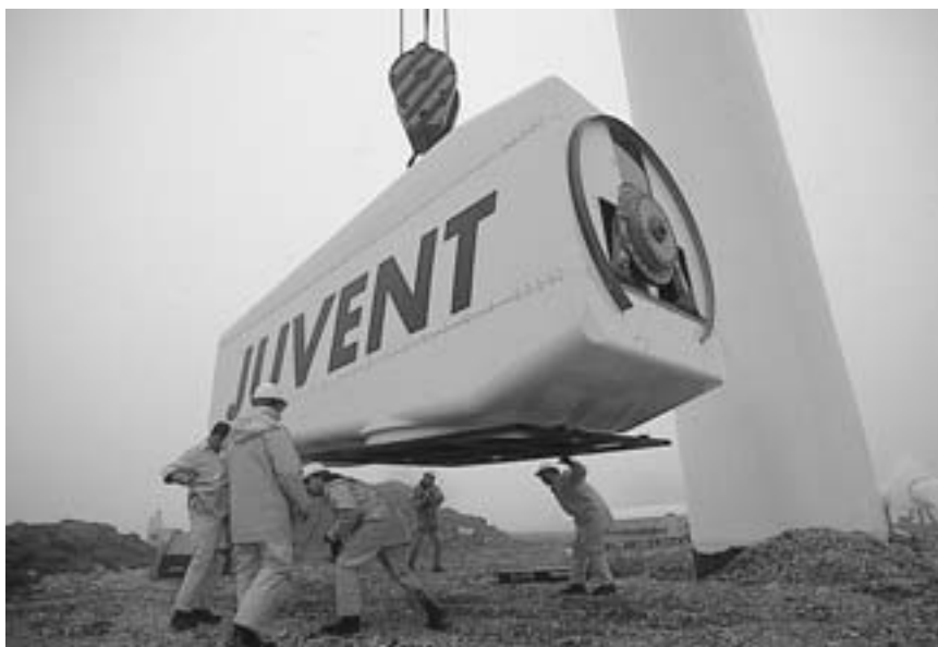
La turbine : cœur de l'éolienne.
